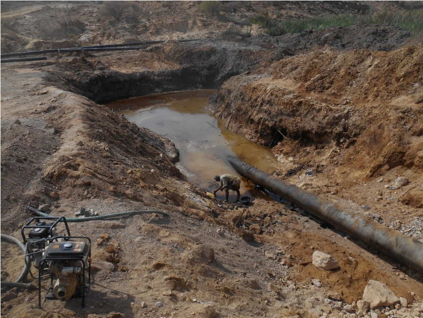
شكل (٦-٦) الحفر العشوائي للوصول الى منطقة التسرب
