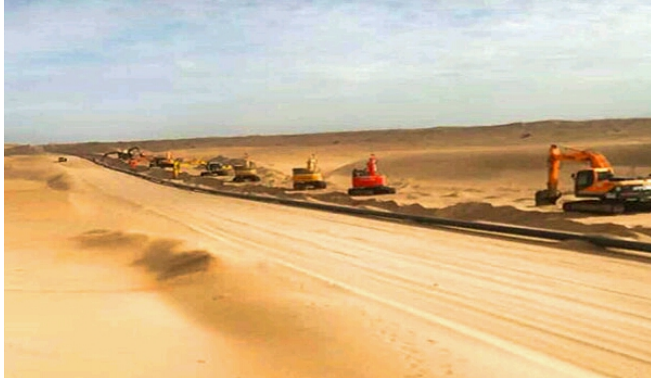
شكل 3-4 اعمال مد خط انبوب النفط بين قطاع (٤) وقطاع (٥)
