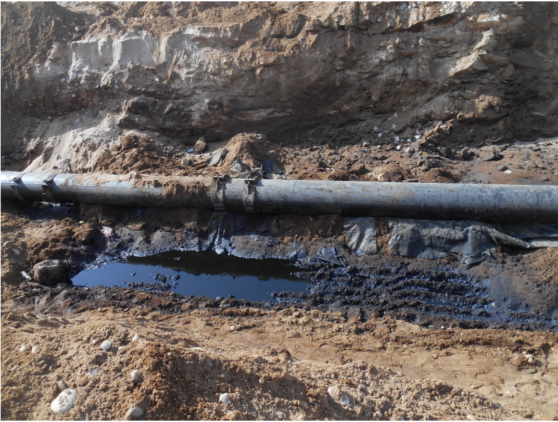
شكل رقم (٧-٣) عمليات الحفر للوصول الى الانبوب
