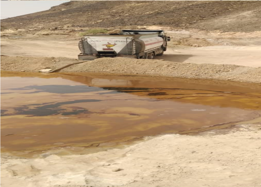
شكل (٦-١٦) احواض التجميع للتخلص من الماء الملوث بالنفط وذلك بالفصل التقليدي وتظهر عليها البقع النفطية
